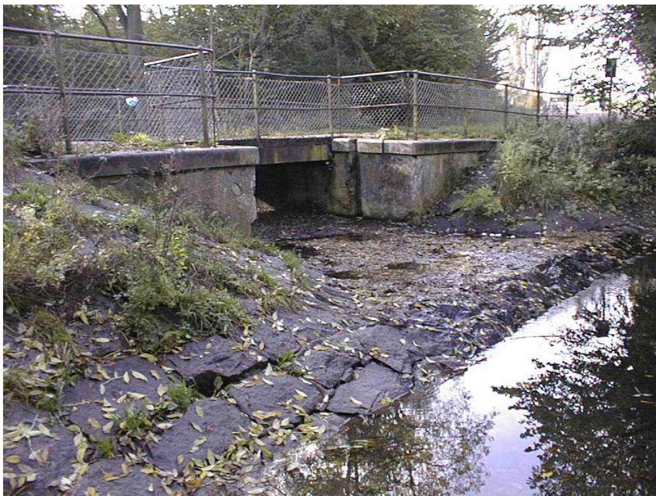
figur 11. Øverst: afskærmning af særligt farlige steder. Nederst: rækværk på spærredæmningen
