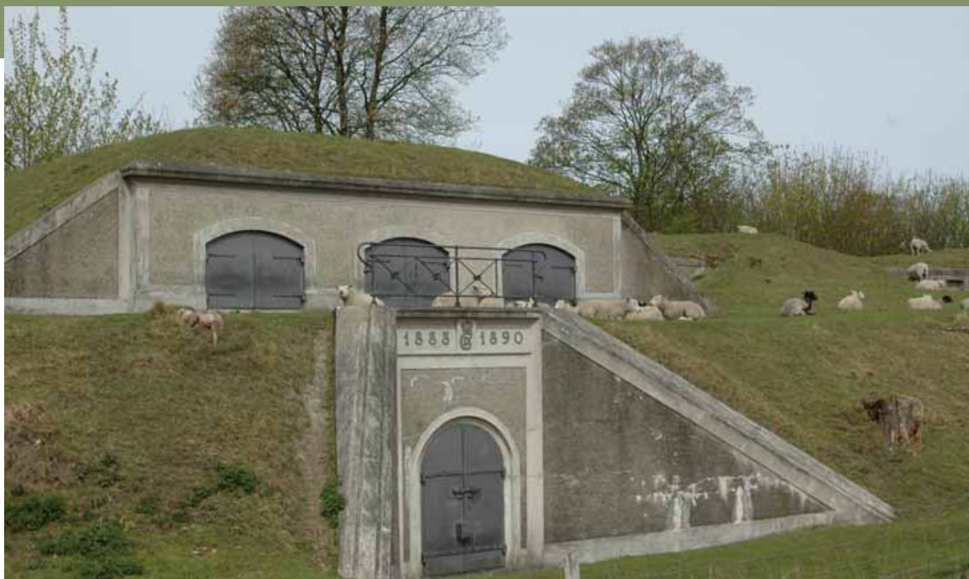
Forsvarsanlægget, som det så ud, da det blev bygget, kan ses på den historiske strækning
